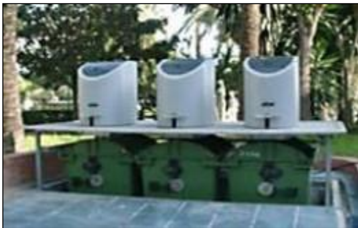
Εικόνα 10.10 Υπόγειο σύστημα απορριμμάτων.
