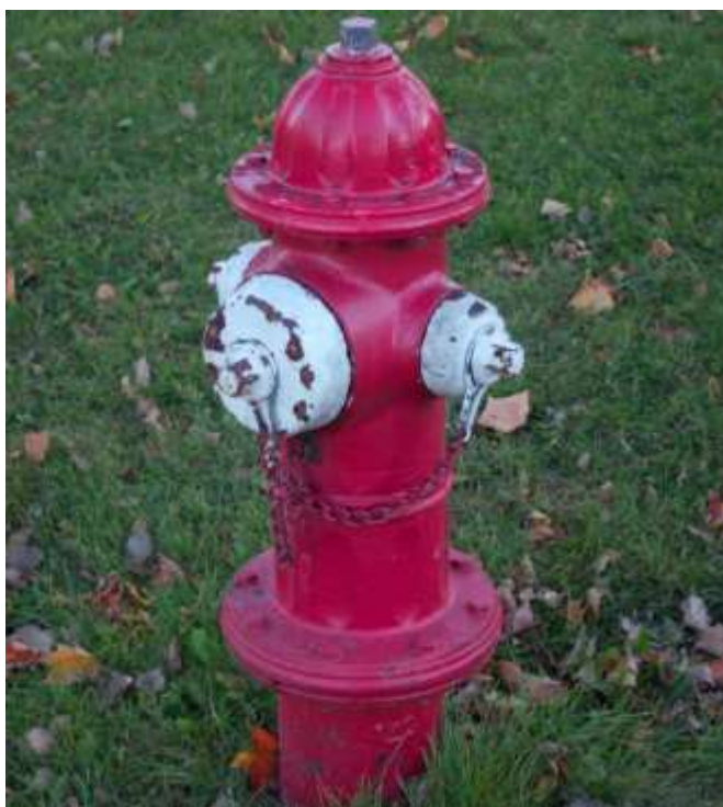
Εικόνα 6.7 Πυροσβεστικός κρουνός ( https://commons.wikimedia.org/wiki/File:Fire_hydrant_6.jpg - By Dori (Own work) [Public domain], via Wikimedia Commons).
